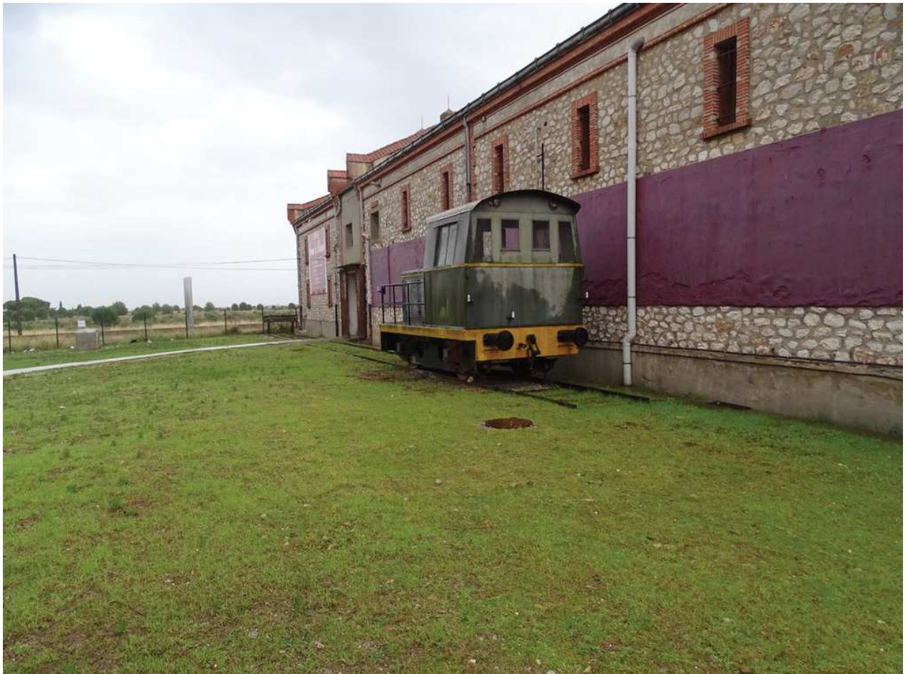
Fig. 3. Cave Arnaud de Villeneuve vue d'une partie des anciens bâtiments Byrrh (source : Jean-Pierre Wolff)
